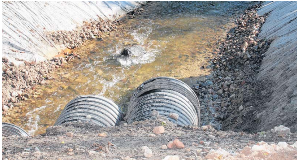
Für den Bau der Fischaufstiegsstelle Buschmühl wurde das Wasser des Augraben umgeleitet. So können die Bauarbeiter im trockenen Flussbett die Stufen setzen.
