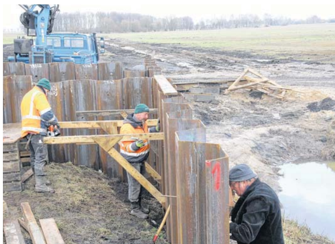
Momentan laufen die Vorbereitungen für das Betonieren der Holme auf der Ostseite der künftigen Brücke.
