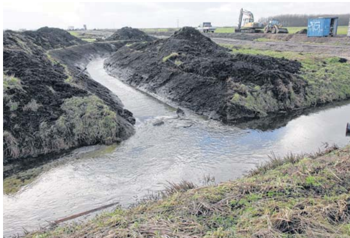
Gegenwärtig wird der Bach um die Baustelle herumgeleitet.
