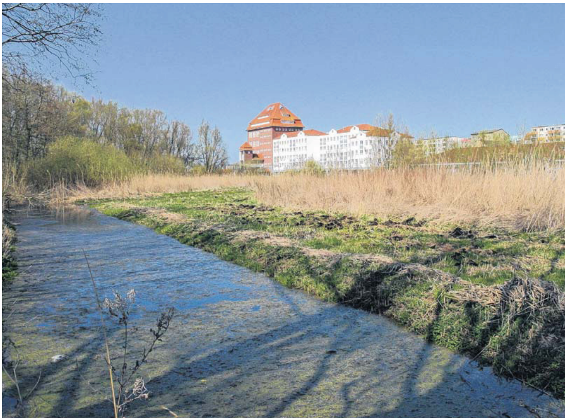
Die Renaturierung des Schmalzgraben-Polders war eines der Projekte des Wasser- und Bodenverbandes Untere Tollense/Mittlere Peene in den vergangenen Jahren.
