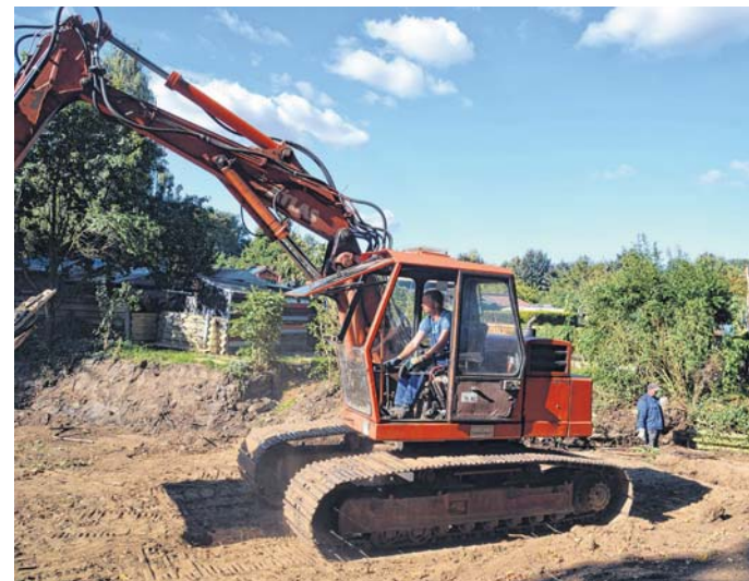
Mit Hilfe des Baggers werden die alten Planken abtransportiert.
