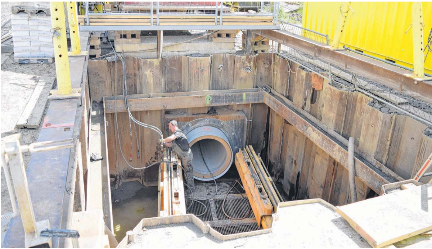
Hier liegen Steine im Weg und so wird es erstmal an andere Stelle am Holländer Gang weitergehen. Dieses Problem soll künftig allerdings mit einer anderen Variante umgangen werden. FOTO: BIRGER SCHÜTZ
