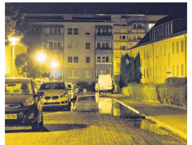
Die Wassermassen traten durch einen zwei Meter langen Riss aus. FOTO: FELIX GADEWOLZ
