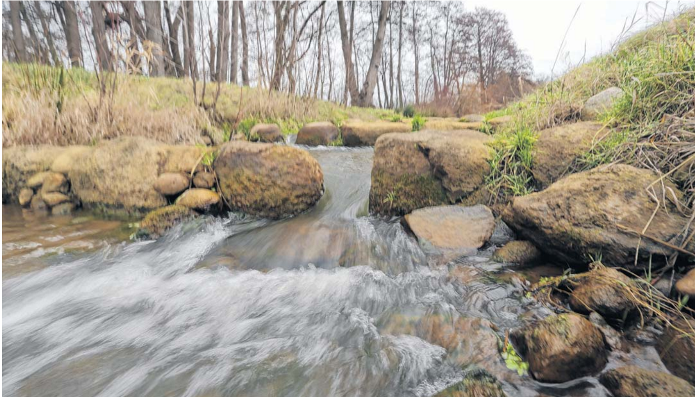
Ökologischer Gewässerumbau beispielsweise durch den Bau von Fischtreppen wie hier bei Sommersdorf ist ein Teil der Arbeiten der Wasser- und Bodenverbände. Dabei ähneln sich die Probleme, gleichgültig, ob es der Verband „Obere Peene“ oder „Untere Tollense/Mittlere Peene“ ist. FOTO: GEORG WAGNER
